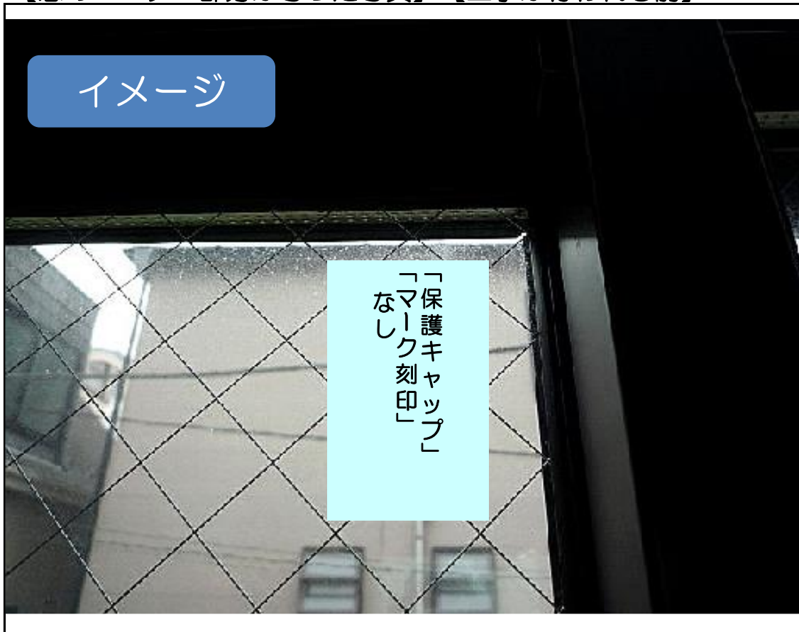
【窓のコーナー部分が写った写真】 【工事が行われる前】
