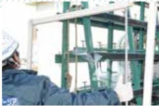
▲ 取付専用グレチャンによる施工
