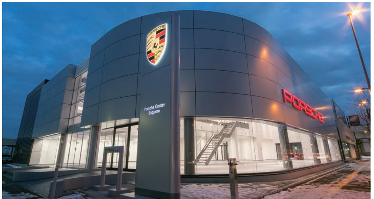
●ポルシェセンター札幌(北海道) 設計:三和シーエム 施工:東急建設
