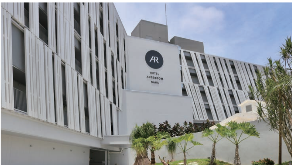
●ホテル アンテールーム 那覇(沖縄) スーパースペース
