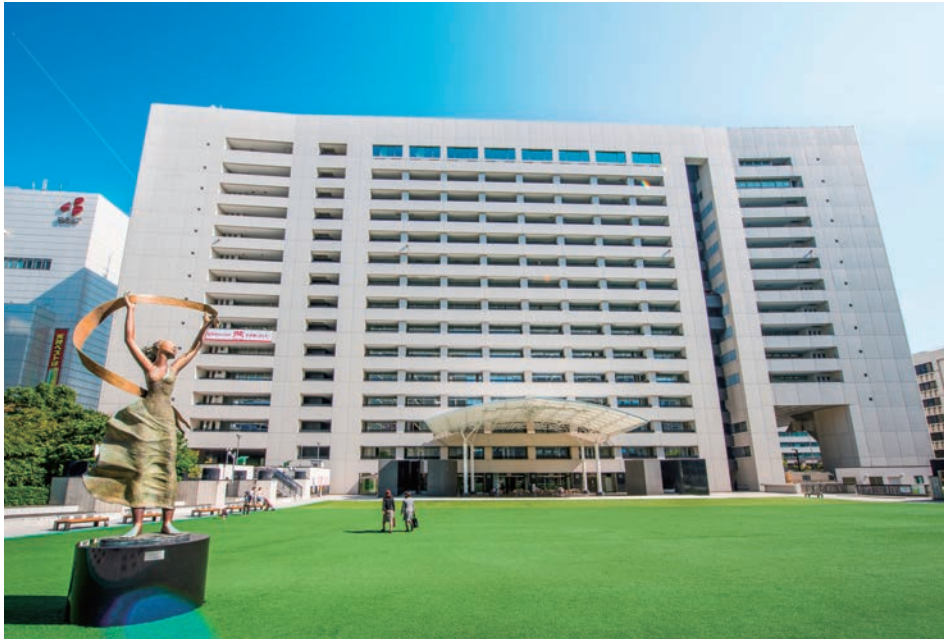
●福岡市役所(福岡) スペースアークル(西面)
