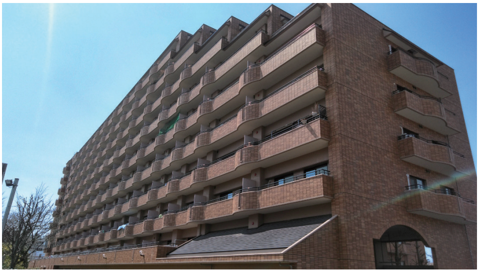
●朝日プラザ柏木(宮城・全住戸改修) スペーシア
