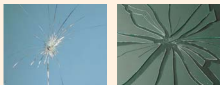
スクールラミペーンの破損状況 フロート板ガラスの破損状況
