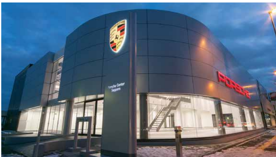
●ボルシェセンター札幌(北海道) 設計:三和シーエム 施工:東急建設
