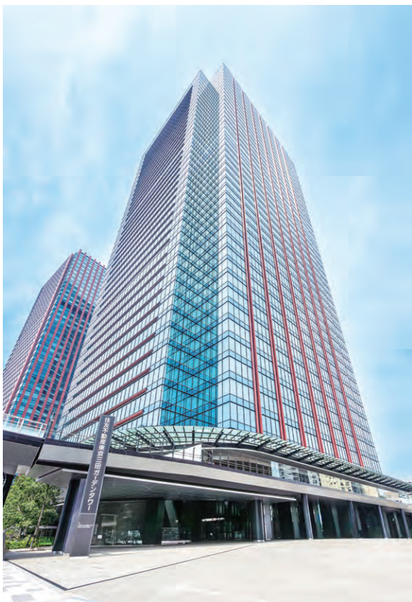
●住友不動産東京三田ガーデンタワー(東京) 設計:久米設計 施工:大林組
