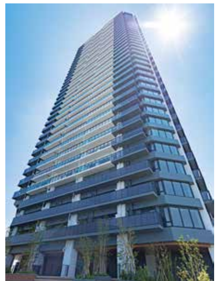
●ザ・タワー十条(東京) 設計・施工:前田建設工業
