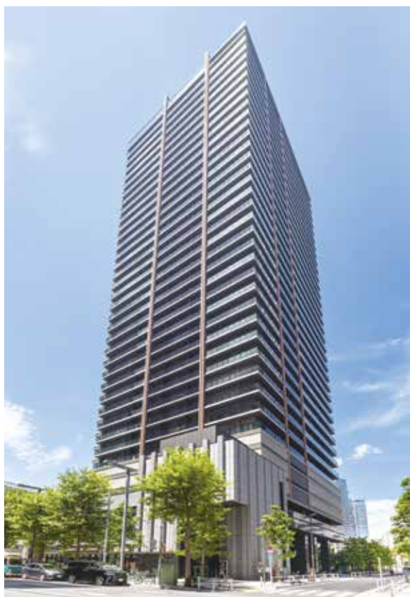
●シティータワー新宿(東京) 設計:アール・アイ・エー 施工:大成・五洋建設共同企業体
