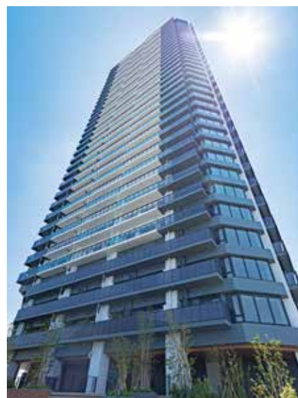
●ザ・タワー十条(東京) 設計・施工:前田建設工業
