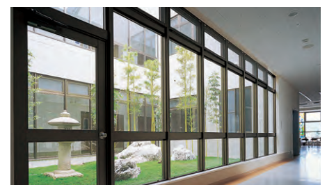
3 防火性能に加えて、「ガラスを用いた開口部の安全設計指針」によって、安全ガラスの使用が求められている建築物。特に人体衝突のおそれの高いドアやその周辺部。
