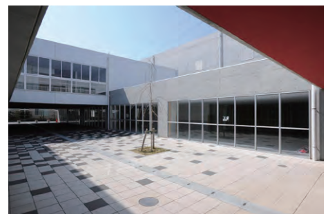
●横浜市立あかね台中学校（神奈川） 設計：みかんぐみ 施工：小俣・六国・日成建設共同企業体
