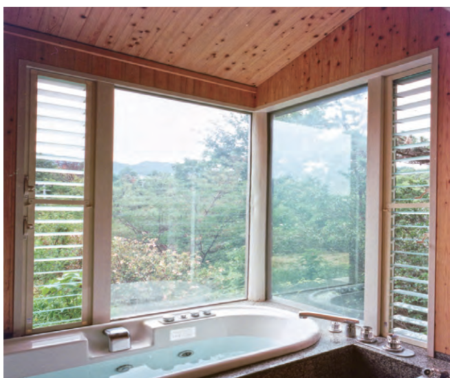
●甲陽園目神山地区住宅(兵庫) 用途: 住宅窓 目的: プライバシー 電圧ON時(透明)
