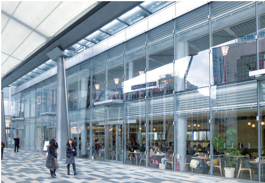
●東京駅八重洲口 グランルーフ(東京) 設計:日建設計・ジェイアル東日本建築設計事務所JV 施工:鹿島建設・鉄建建設JV 強化合わせガラス
