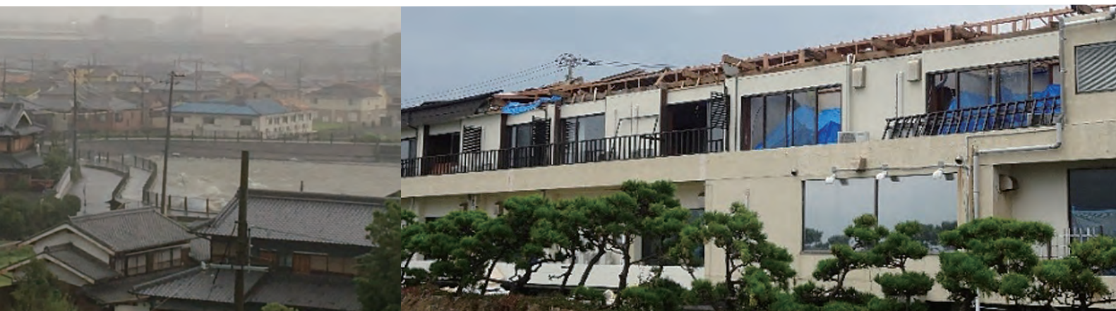
木造部分の屋根とベランダの被害状況(南房総市内) 〔国立研究開発法人建築研究所ホームページより転載〕
